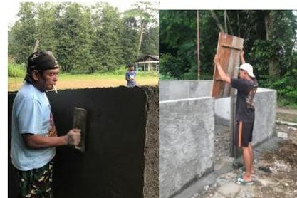
**Gambar.6.** Proses aci bagian luar dan pemasangan pintu
