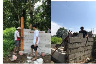
**Gambar.4.** Pemasangan hebel dan pemasangan bekisting
